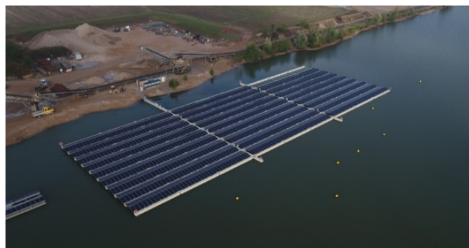
Das schwimmende Kraftwerk besteht aus 90 kleinen Pontons, auf denen 2000 Solarmodule montiert sind. Foto: Hülskens Holding GmbH & Co. KG
