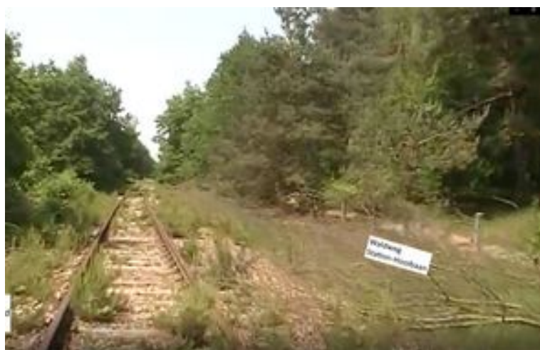
Gelände des ehem. Bhf. Vlodrop, Blick in Richtung Roermond
